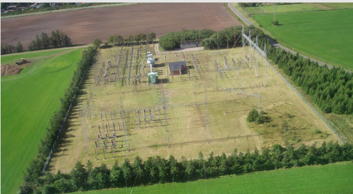
Eksempel på en højspændingsstation. Her skråfoto af station Bredebro (60 kV og 150 kV)
