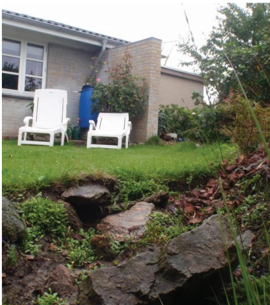
Figur 20: Tagvandet ledes via et rør til regnbedet (i forgrunden skjult under en sten). På nedløbsrøret er desuden opsat en tønde til opsamling af regnvand. Slagslunde, Egedal Kommune. Foto Orbicon.
