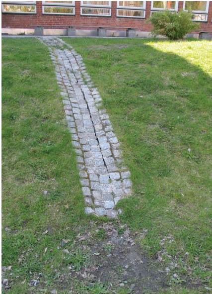
Figur 9: Afledning af regnvand til græsplæne i Augustenborg, Malmø. Foto Orbicon
